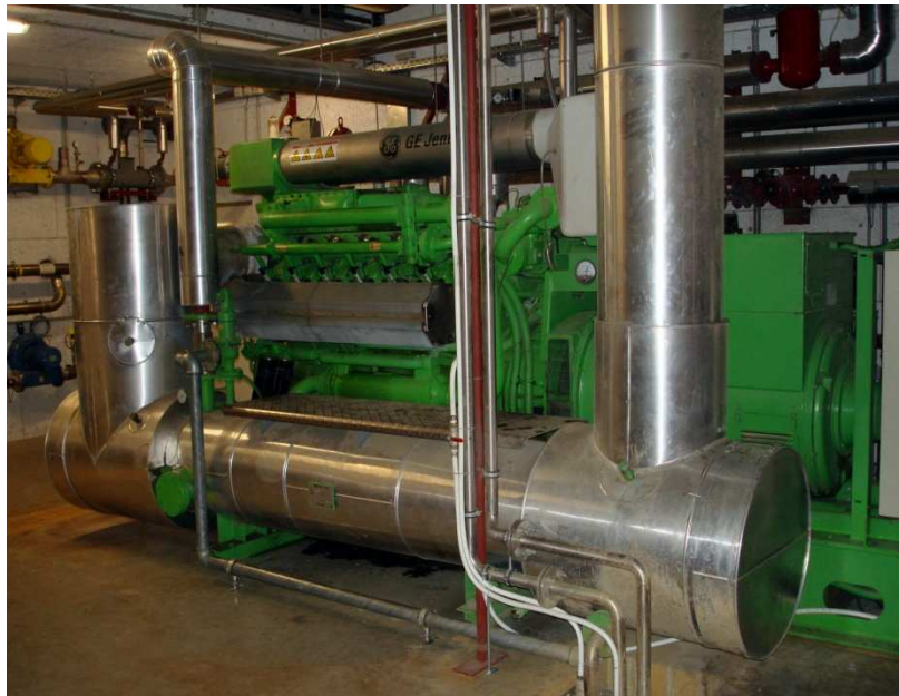
Abbildung 11: Gasmotor Jenbacher V12 625 kW in Wallsee, 19.10.09
