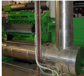
Abbildung 7: Gasmotor Jenbacher
